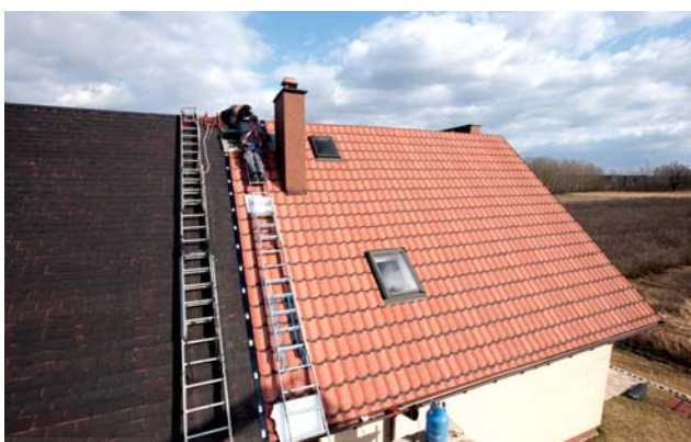
W trakcie montażu RDI 3D®
