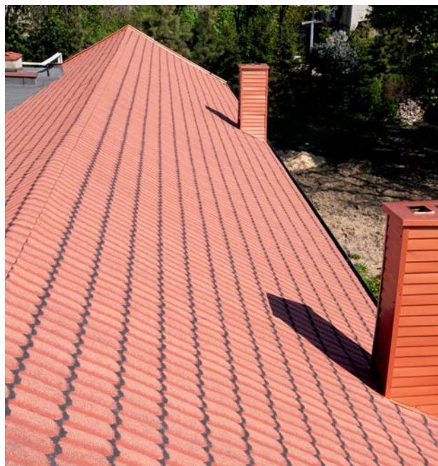
Dach na budynku gospodarczym przy Parafii św. Anny w Łodzi – dotychczas pokryty był brzydką czarną papą. Po pokryciu go Rolowaną Dachówką Icopal 3D® nabrał całkowicie nowego wyrazu
