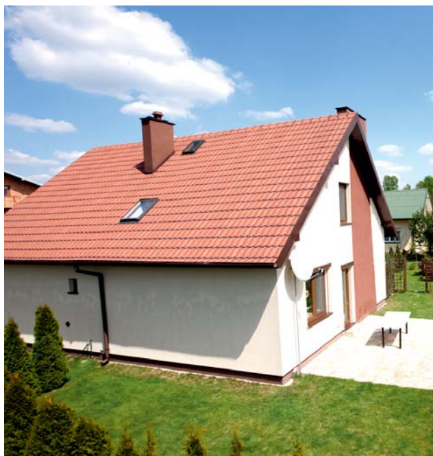
Dach budynku mieszkalnego zlokalizowany w Wierzchach Parzeńskich koło Bełchatowa. Do momentu pokrycia go Rolowaną Dachówką Icopal 3D® pokryty był gontami papowymi, które utraciły swoją szczelność i podczas jednej z wiosennych wichur odfrunęły z dachu
