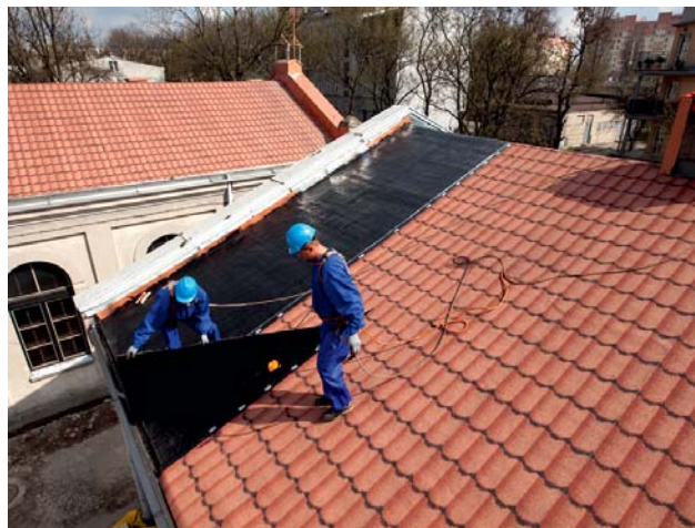
W trakcie montażu RDI 3D®
